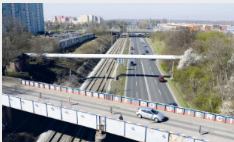
► Objęty przebudowę wiadukt Fot. UM Zabrze
