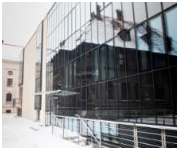
► Szklana elewacja dobudowanej części gmachu Fot. Paweł Janicki/Teatr Nowy
