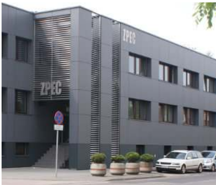
► Siedziba Zabrzańskiego Przedsiębiorstwa Energetyki Ciepłej Fot. ZPEC
