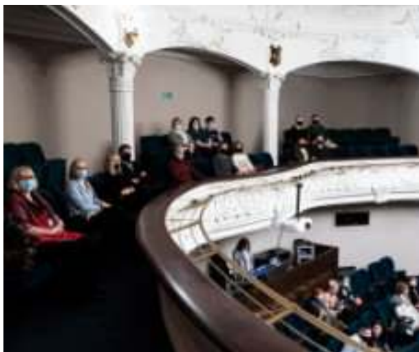
► Na widowni została zamontowana klimatyzacja Fot. Paweł Janicki/Teatr Nowy
