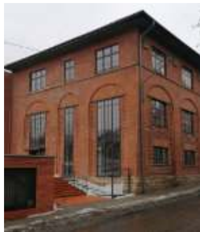
► Widok budynku od frontu Fot. Igor Cieśllicki
