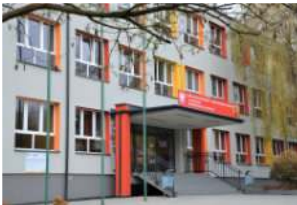
► Termomodernizacje kolejnych szkół i przedszkoli Fot. UM Zabrze
