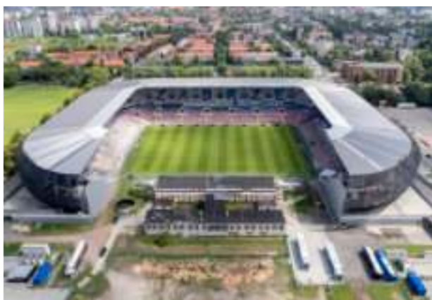
► Dokończenie budowy Areny Zabrze Fot. UM Zabrze
