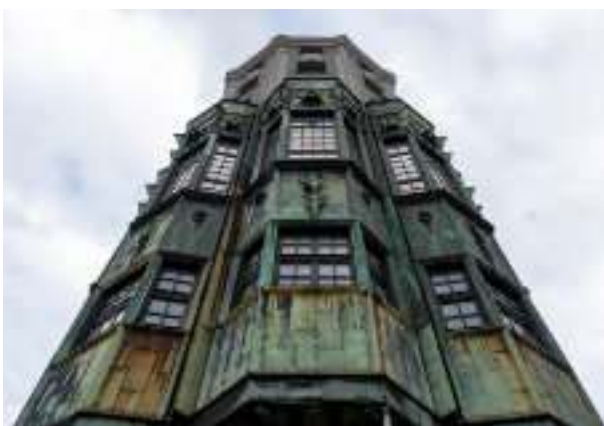
► Rewitalizacja dawnego hotelu Admiralspalast Fot. UM Zabrze
