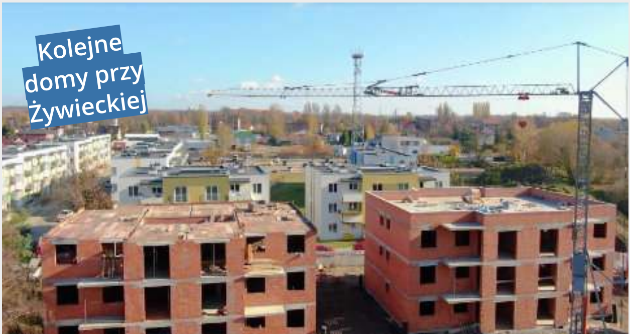
Podpisano umowę dotyczącą budowy trzech kolejnych bloków na osiedlu przy ul. Żywieckiej
