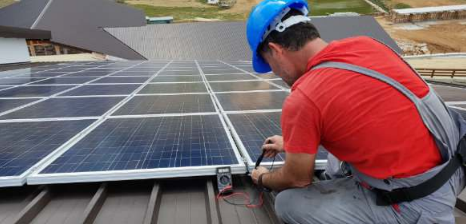
► Montaż instalacji fotowoltaicznej Fot. pixabay
