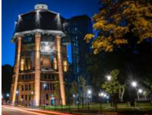
► Wieża ciśnienia przy ul. Zamoyskiego Fot. UM Zabrze
