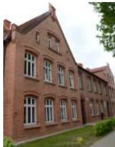
► Szkoła przeszła termomodernizację Fot. UM Zabrze
