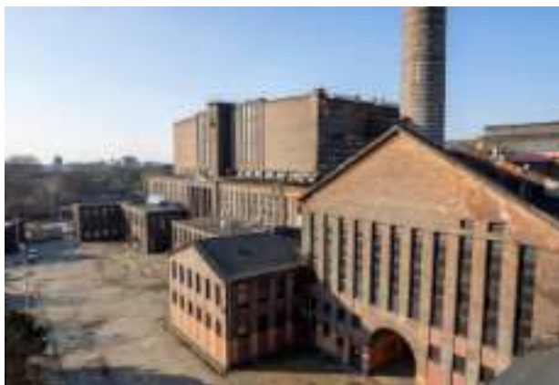
► Rewitalizacja kompleksu dawnej elektrociepłowni Fot. UM Zabrze
