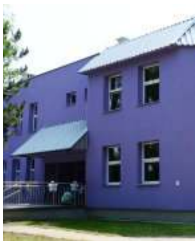
► Wyremontowane Przedszkole nr 36 Fot. UM Zabrze
