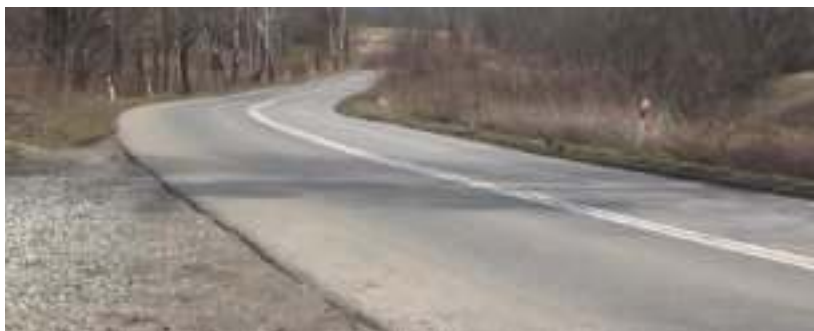
► Modernizacja obejmie prawie 300 metrów drogi Fot. TVZ
