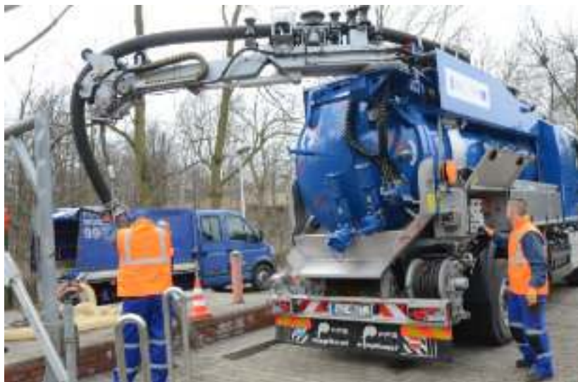
► Nowoczesny samochód służący do czyszczenia sieci Fot. Igor Cieśliski
