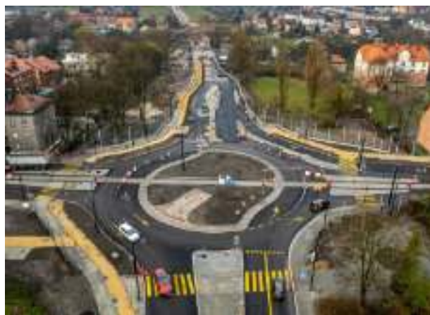
► Przedłużenie alei Korfańtego Fot. UM Zabrze
