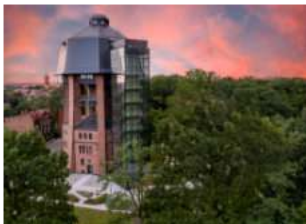
► Rewitalizacja wieży ciśnień przy ul. Zamoyskiego Fot. UM Zabrze
